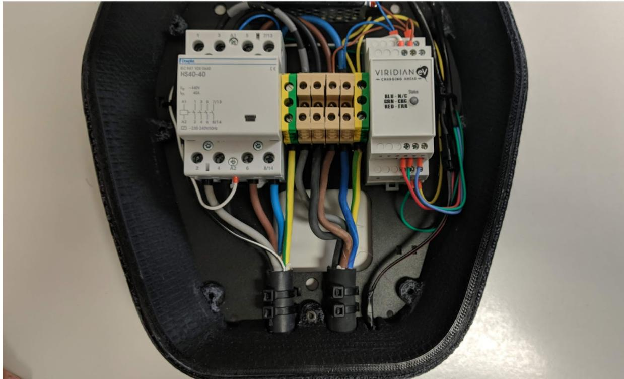
Figura 9. Stazione di ricarica dazeBox completamente cablata e pronta per essere chiusa.
